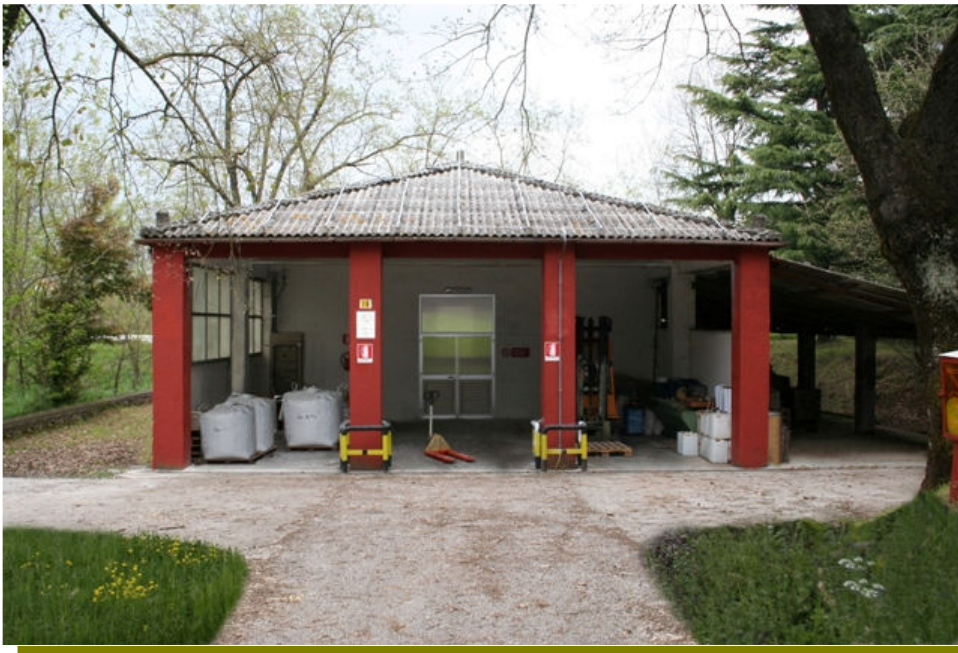
locale miscelazione e stoccaggio materie prime
