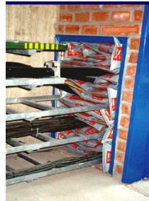
Attraversamenti di servizi tecnici
