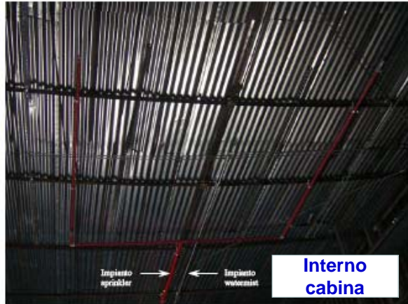
Foto 3: Vista degli impianti di spegnimento, sprinkler e watermist installati sotto il soffitto del locale di prova ad un'altezza di 6,00 m.
